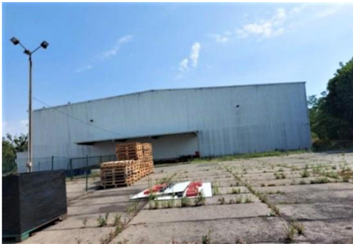
Budynek hali magazynowej (widok od strony bocznej rampy)
