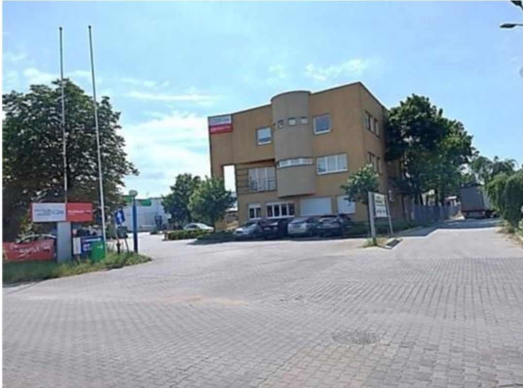
Budynek administracyjno-biurowy (widok od strony ul. Budowlanych)
